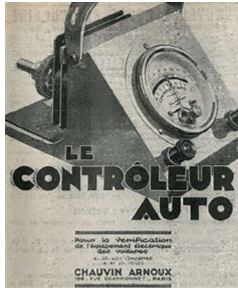
Un appareil dédié. Appareil de contrôle spécialisé pour les mesures sur l'équipement électrique des automobiles (hé oui, déjà !!). Publicité parue dans la revue La nature N°2908 de 1925. Vendu encore au Bazar de l'Hôtel de Ville en 1933 au prix de 410 francs. (10)
