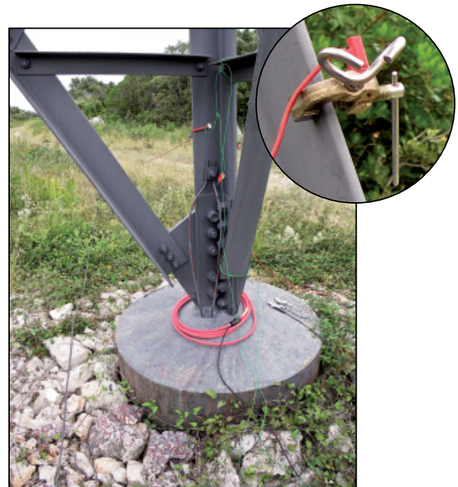
El uso de sensores AmpFLEX™ proporciona una gran flexibilidad en cuanto a configuración del poste se refiere
