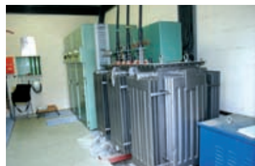
Transfo HT/BT et cellules protections
