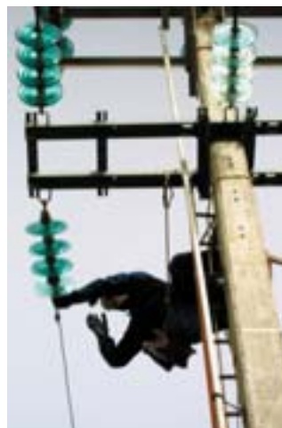
Un élève en formation sur un des pylônes du centre
